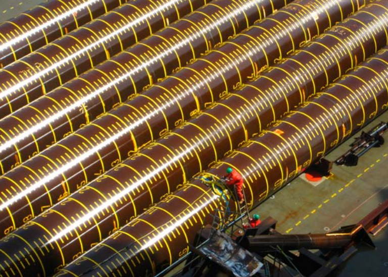
Montaż okablowania pala do prób dynamicznych
