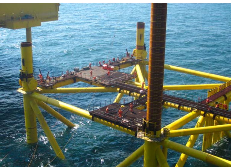
Budowa fundamentu kratownicowego pod Morską Podstacją Elektryczną
